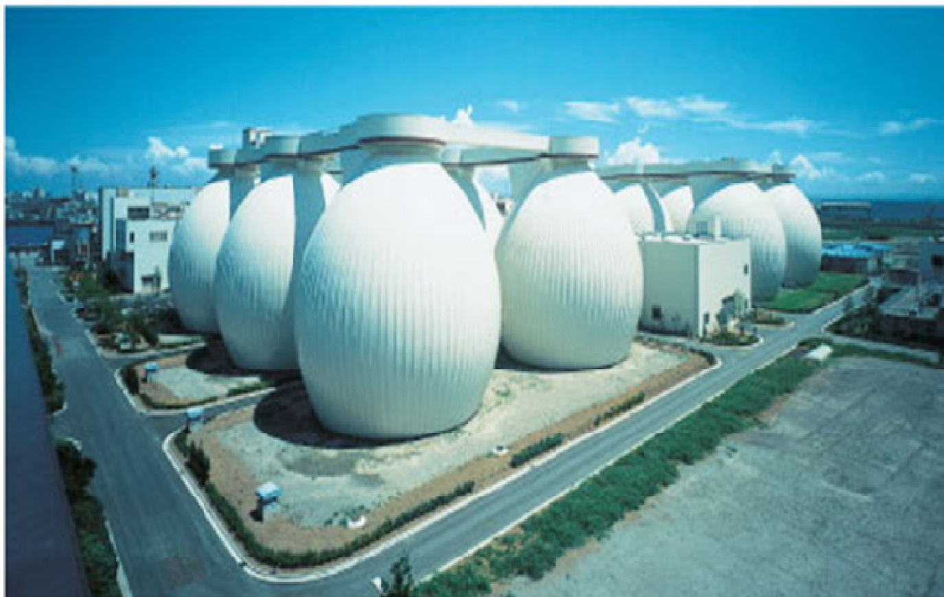
横浜市北部汚泥処理センターの厭気発酵タンク。迫力ある白の空間が広がる
