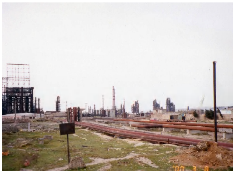
製油所から伸びるパイプライン
