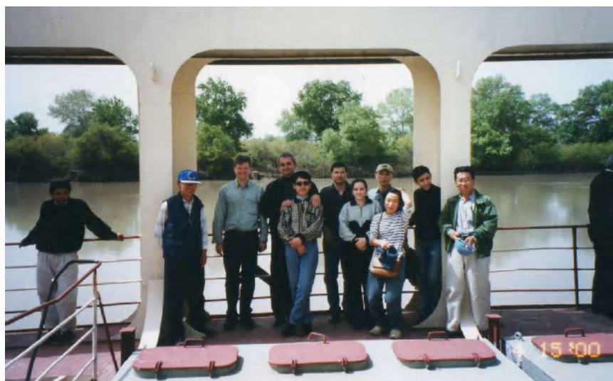
バクーの水道用水を取水する固定船（水位に応じて上下する）
